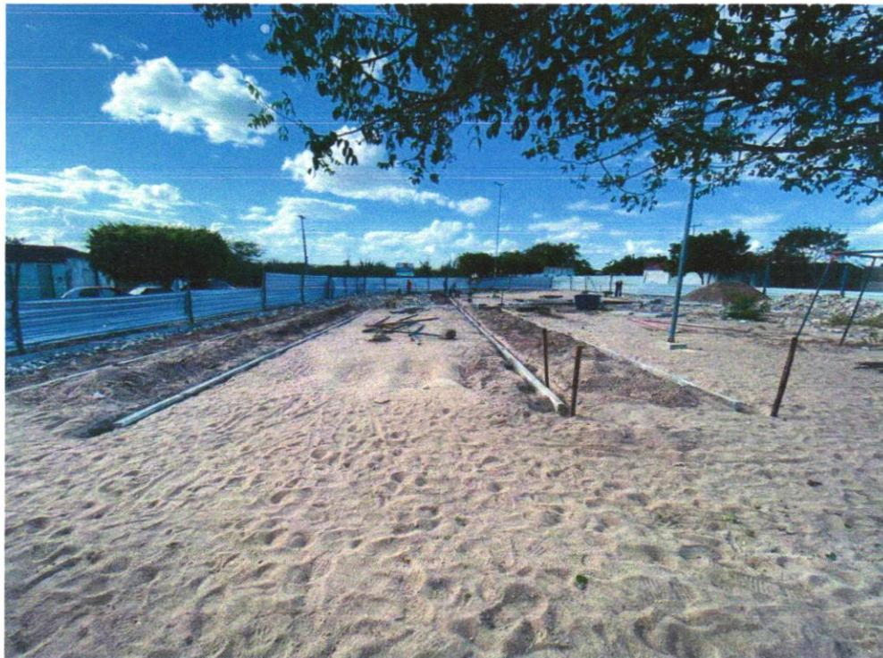
Foto 01 - ATERRO MANUAL COM SOLO ARGILLO-ARENOSO IMPORTADO E COMPACTAÇÃO MECANIZADA EM CAMADAS DE 0,20 M NO MÁXIMO
